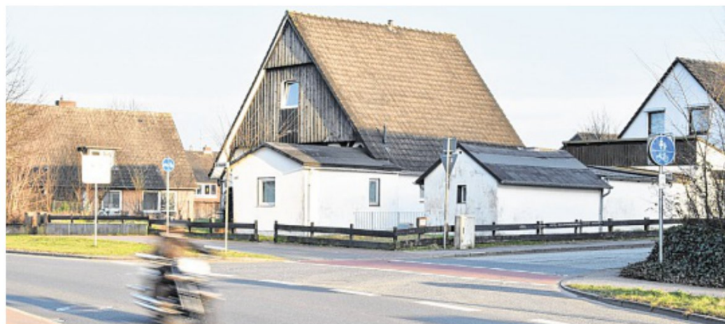
Am Ortseingang von Bad Schwartau soll ein Wohnkomplex entstehen, dem das älteste Haus der Stadt zum Opfer fallen könnte. Drei Vereine versuchen, die Kate zu retten. Foto: Alexander Steenbeck
